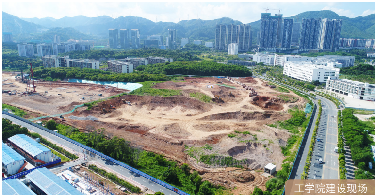
工学院建设现场
