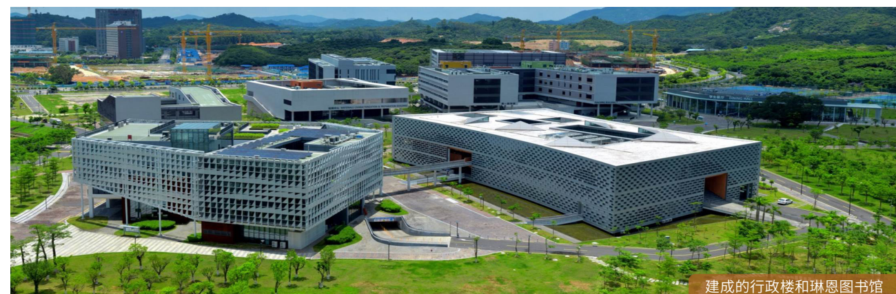
建设中的行政楼和琳恩图书馆
